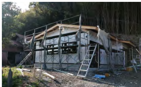
【ミルクプラント工事実施】
